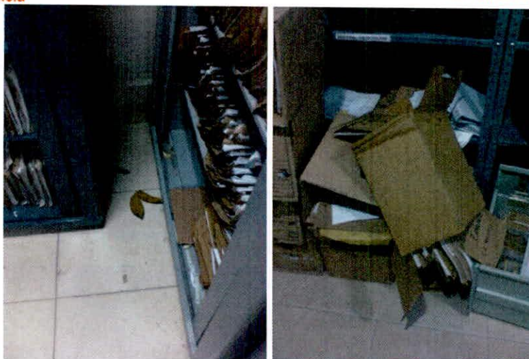
Foto 2: Acumulación de polvo y suciedad lo cual pueden influir en el elevado recuento ambiental
