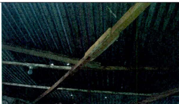
Cubierta depósito de archivo
